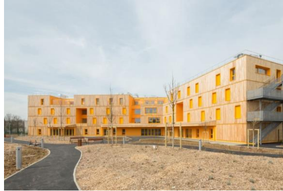
Figura 03 – Vista da Fachada Principal da CRM – Morangis/ FR
